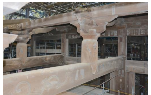
大殿解体修理現場
